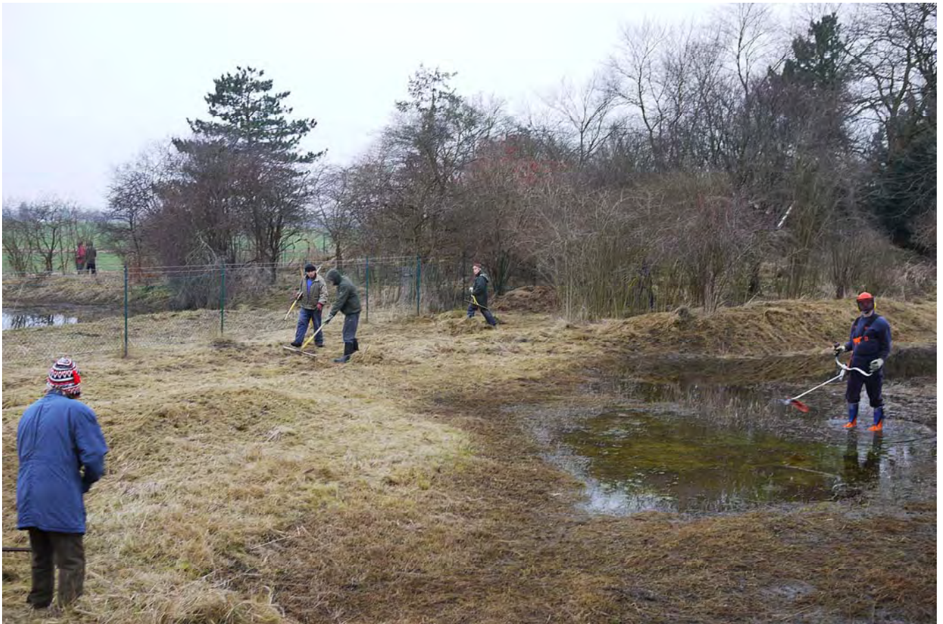
Januar 2011: Arbeiten am Naturdenkmal Salzgraben in Salzdahlum
