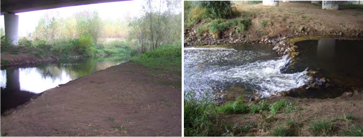
Abb. 6: Schunterkreuzung Autobahnbrücke Hondelage.
