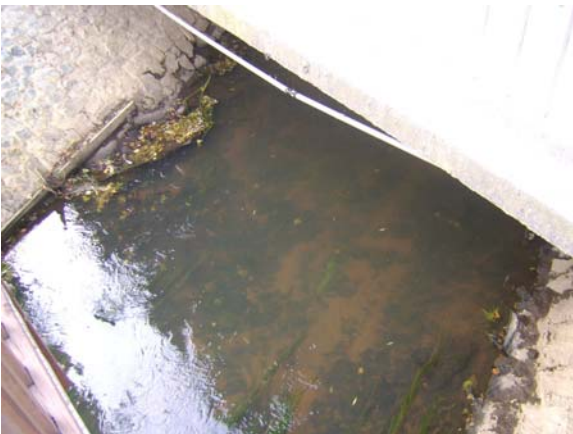
Abb. 7: Brücke Alte Schulstraße.
